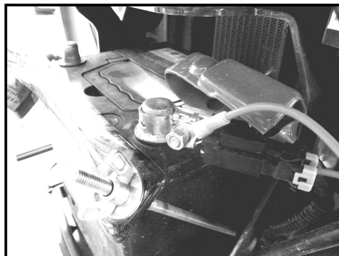
Figure 15 : Installation du fil rouge
